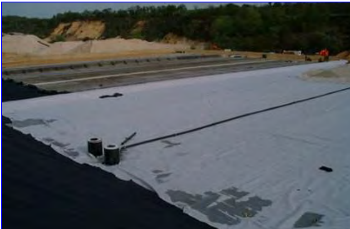
Descarga de la Fosse Marmitaine, Tourville La Rivière (Francia) - 24 000 m 2 MEDIOAMBIENTE / CONFINAMIENTO
