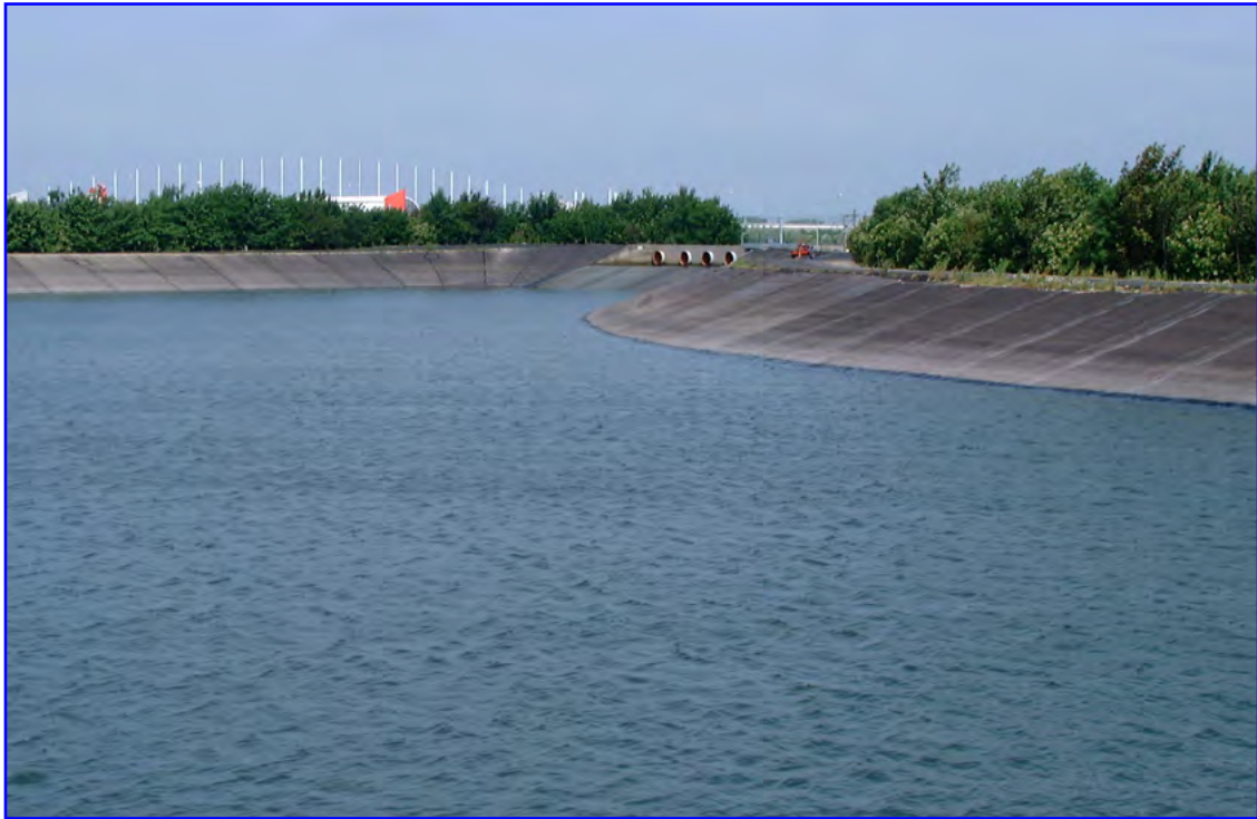
Balsas de la terminal del Eurotunnel, Calais (Francia) - 155 000 m 2 HIDRAULICA / Balsa
