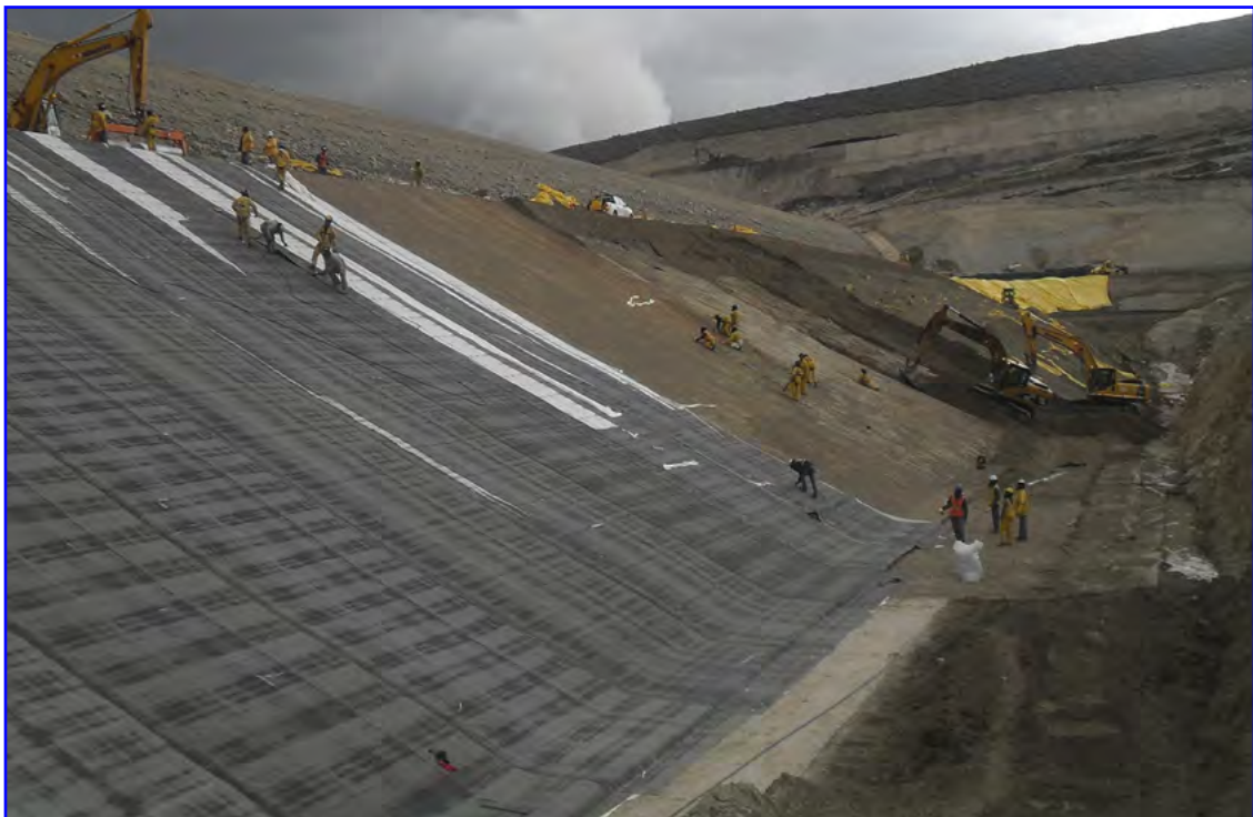
Presa de agua limpia de Chuspiri (Perú) - 63 000 m 2 HIDRAULICA / PRESA
