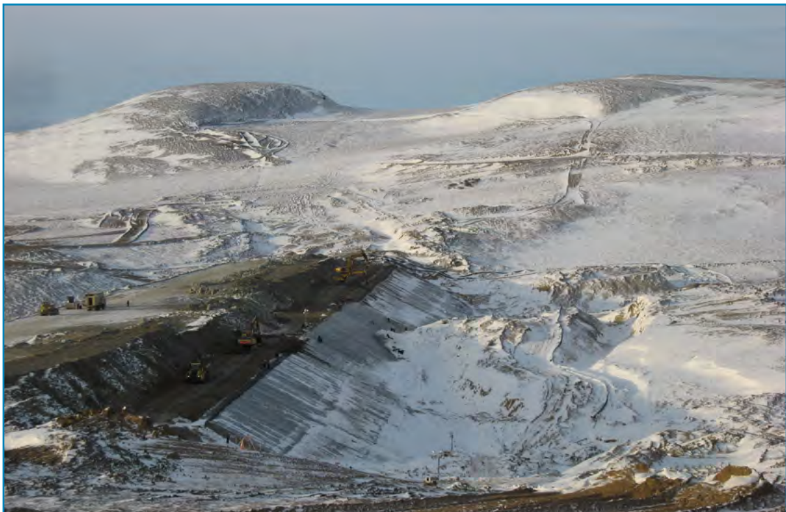
Presa de decantación de aguas contaminadas, Kupol (Rusia) - 100 000 m 2 HIDRAULICA / PRESA
