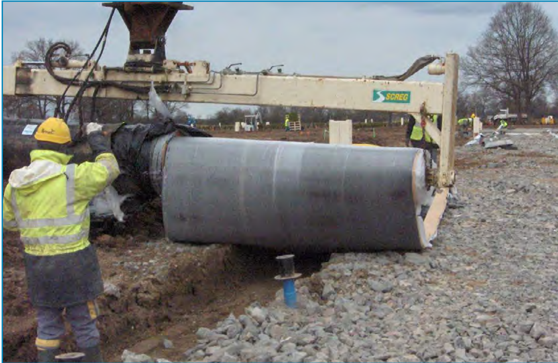
Fosas de cunetas, Saint-Etienne (Francia) - 6 000 m 2 TRANSPORTE / FOSAS DE CUNETAS
