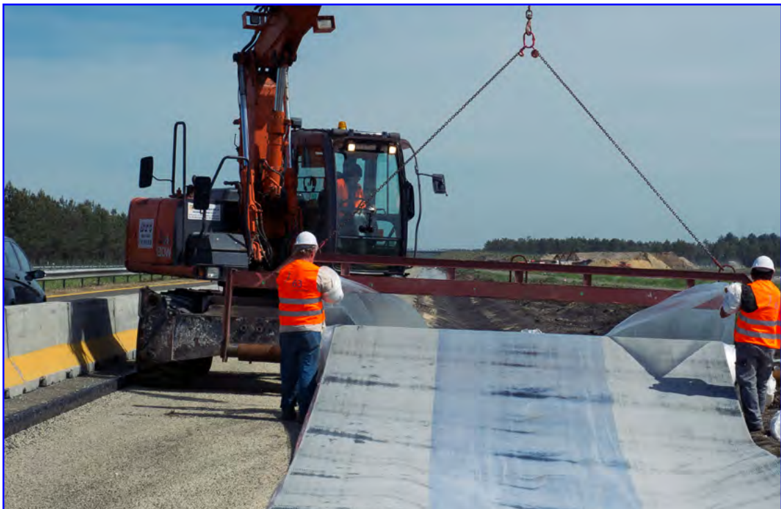
Cunetas, A63 (Francia) - 500 000 m 2 TRANSPORTE / CARRETERAS
