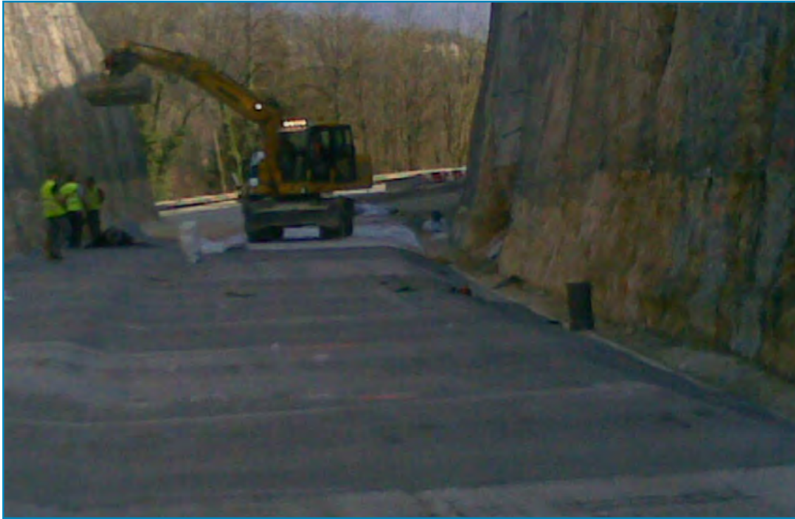
Línea TGV, Nantua (Francia) - 40 000 m 2 TRANSPORTE / VÍAS FÉRREAS
