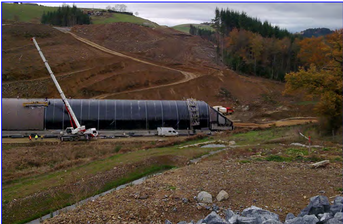
Extrados, A89, Lyon (Francia) - 7 000 m 2 TRANSPORTE / CARRETERAS
