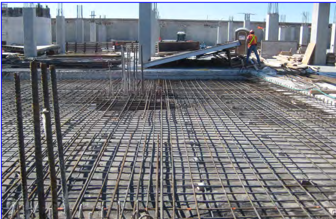
Toronto (Canadá) - 11 000 m 2 MEDIOAMBIENTE / BARRERA BIOGÁS
