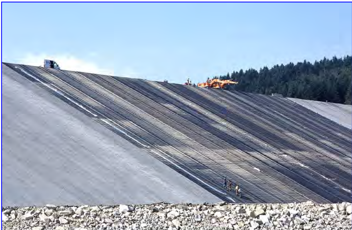
Presa La Galaube, Carcassonne (Francia) - 25 000 m 2 HIDRAULICA / PRESA
