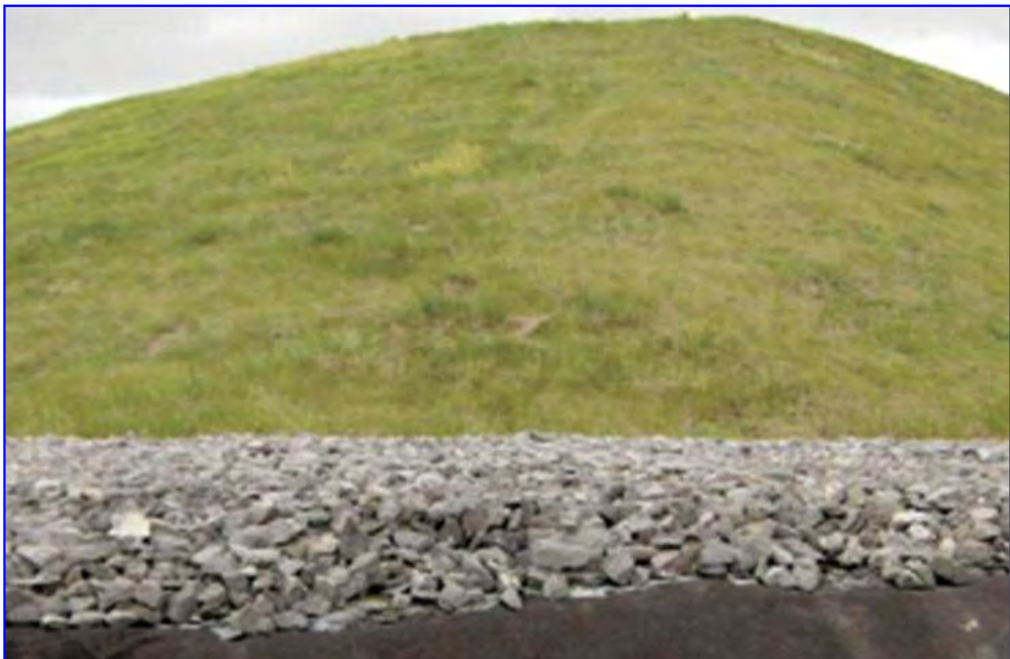
Recubrimiento de un Escombrera, Wattrelos (Francia) - 45 000 m 2 MEDIOAMBIENTE / CONFINAMIENTO
