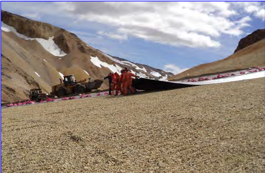
Recubrimiento, mina de Furioso (Chile) - 51 612 m 2 MEDIOAMBIENTE / CONFINAMIENTO
