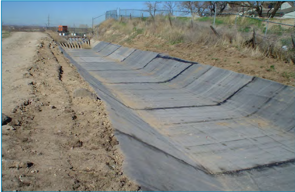
Blagok Canyon (USA) - 2 448m 2 HIDRAULICA / CANALES
