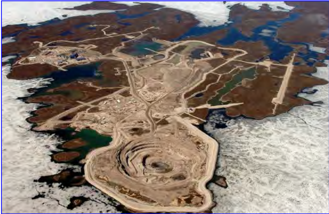
Balsas de residuos mineros, Diavik mina de diamantes (Canadá) - 430 000 m 2 MEDIOAMBIENTE / CONFINAMIENTO
