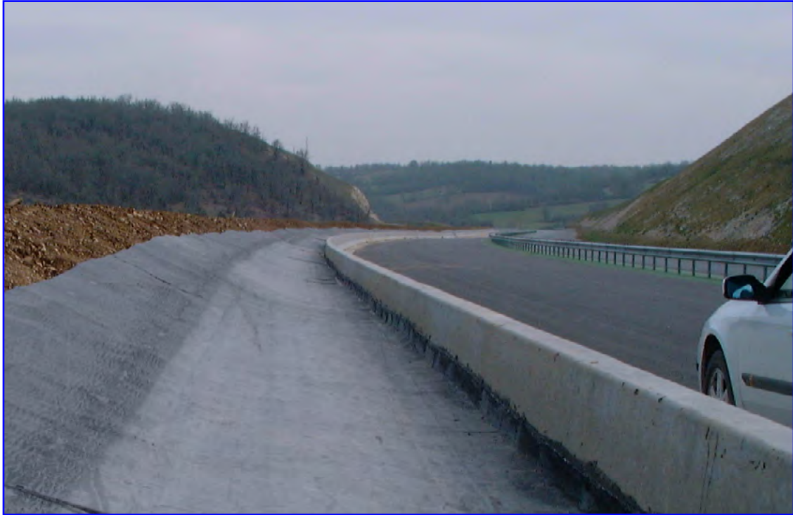
Fosas de cunetas, Autopista 20 (Francia) - 81 000 m 2 TRANSPORTE / CINCUNVALACIÓN
