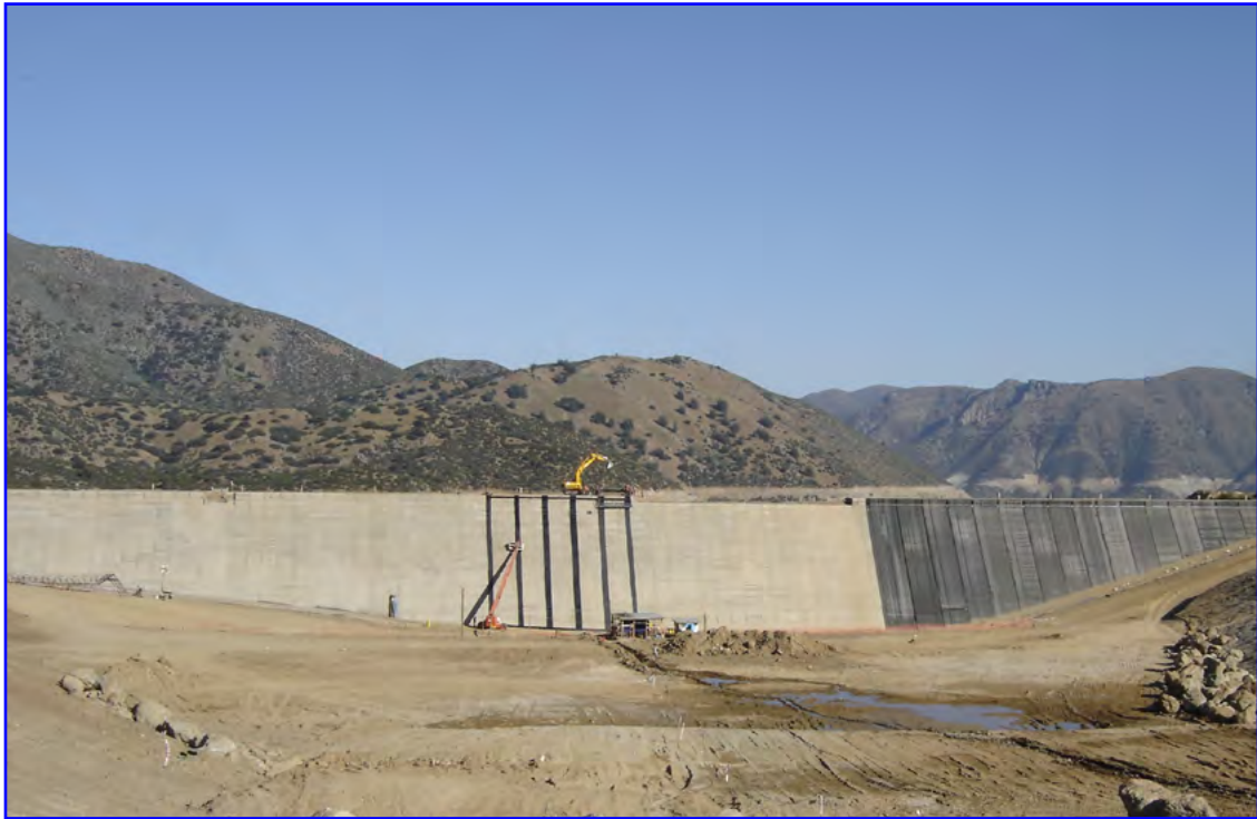
Presa, EL Mauro (Chile) - 10 000 m 2 HIDRAULICA / PRESA
