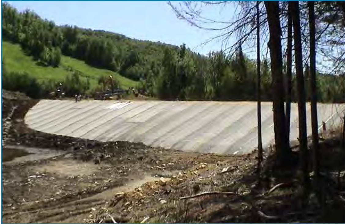
Presa, St-Jovite (Canadá) - 6 000 m 2 HIDRAULICA / PRESA
