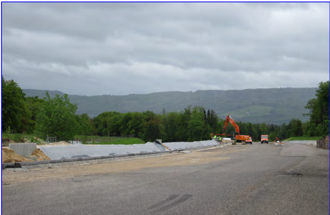
Taludes, A16 (Suiza) - 10 000 m 2 TRANSPORTE / CARRETERAS
