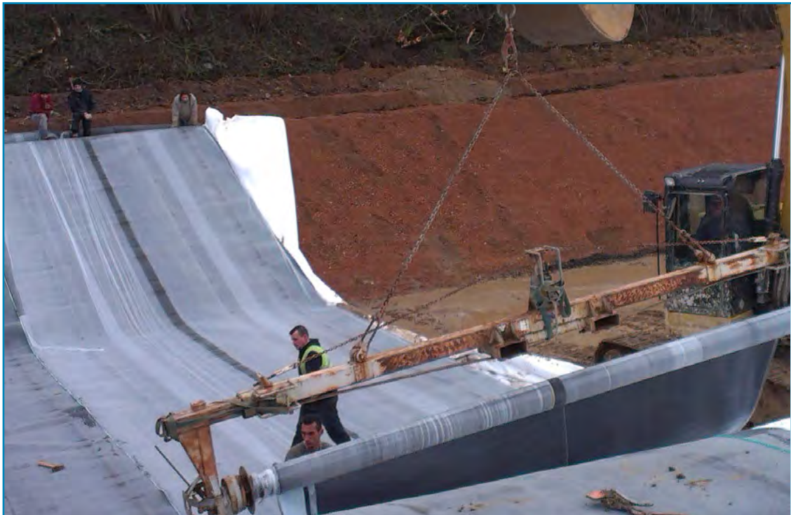
Canales de Unión, Roanne-Digoin (Francia) - 14 000 m 2 HIDRAULICA / CANALES
