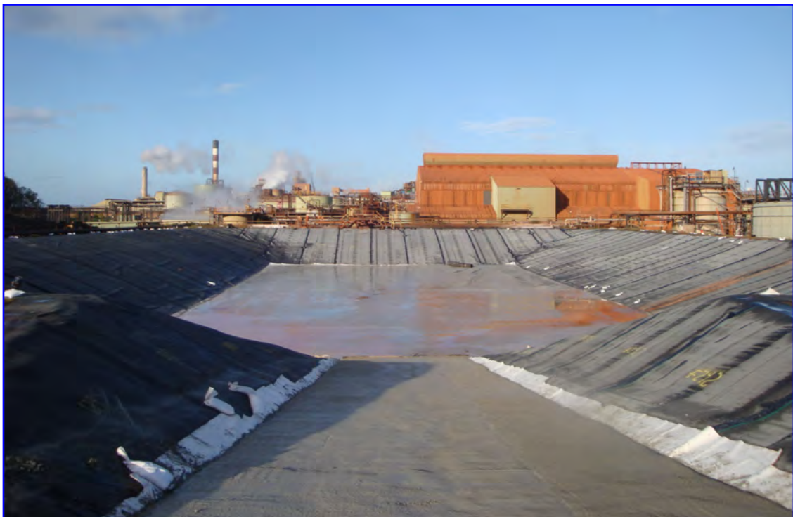
Balsa de decantación de aguas saladas, Rusai (Irlanda) - 6 000 m 2 HIDRAULICA / Balsa
