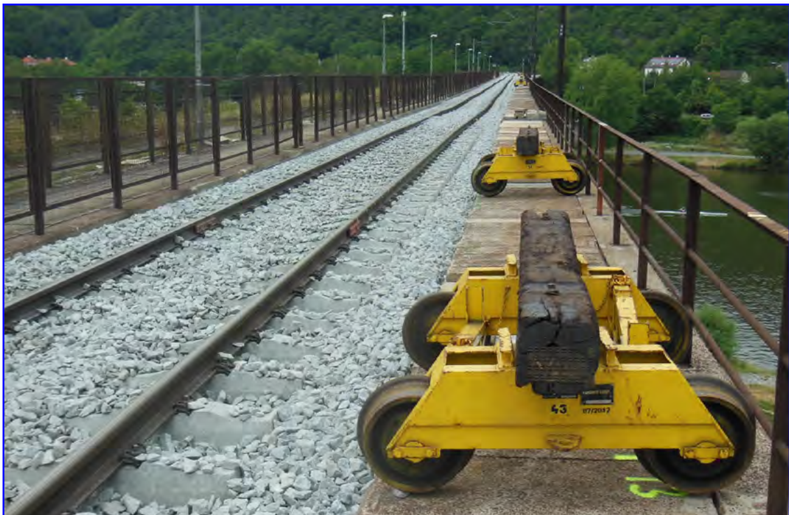
Puente ferroviario, Praga (República Checa) - 5 000 m 2 TRANSPORTE / VÍAS FÉRREAS
