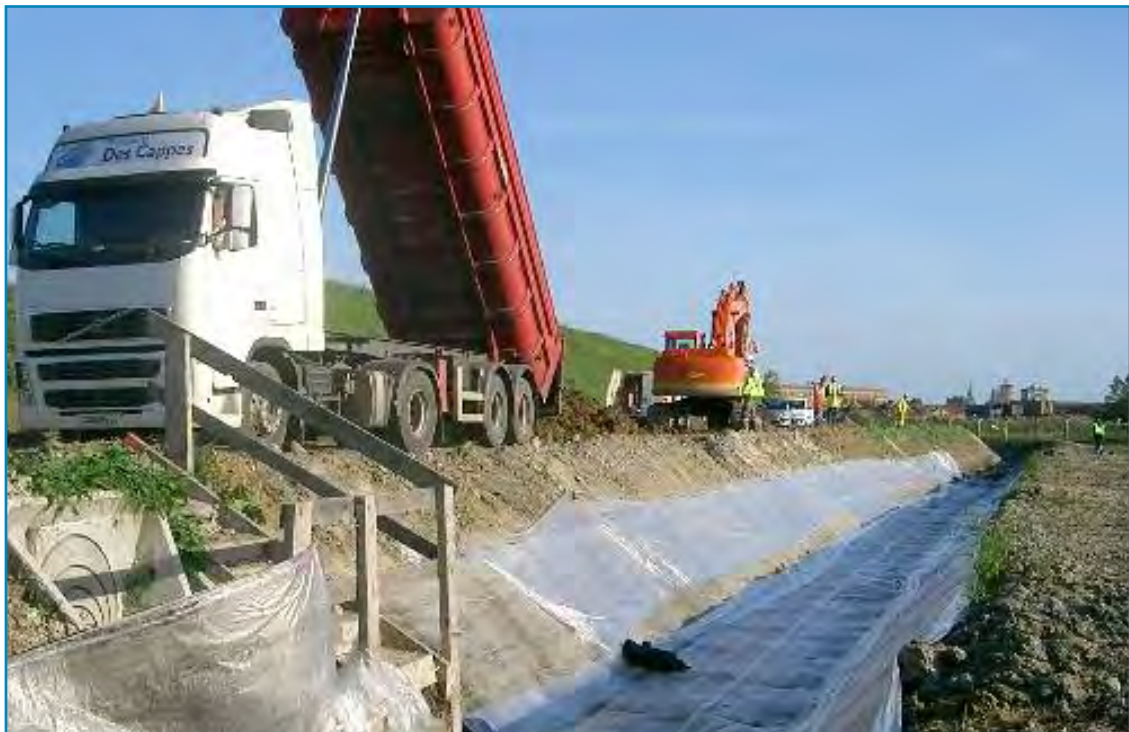
Fosas de cunetas, Delnkerque (Francia) - 16 000 m 2 TRANSPORTE / FOSAS DE CUNETAS
