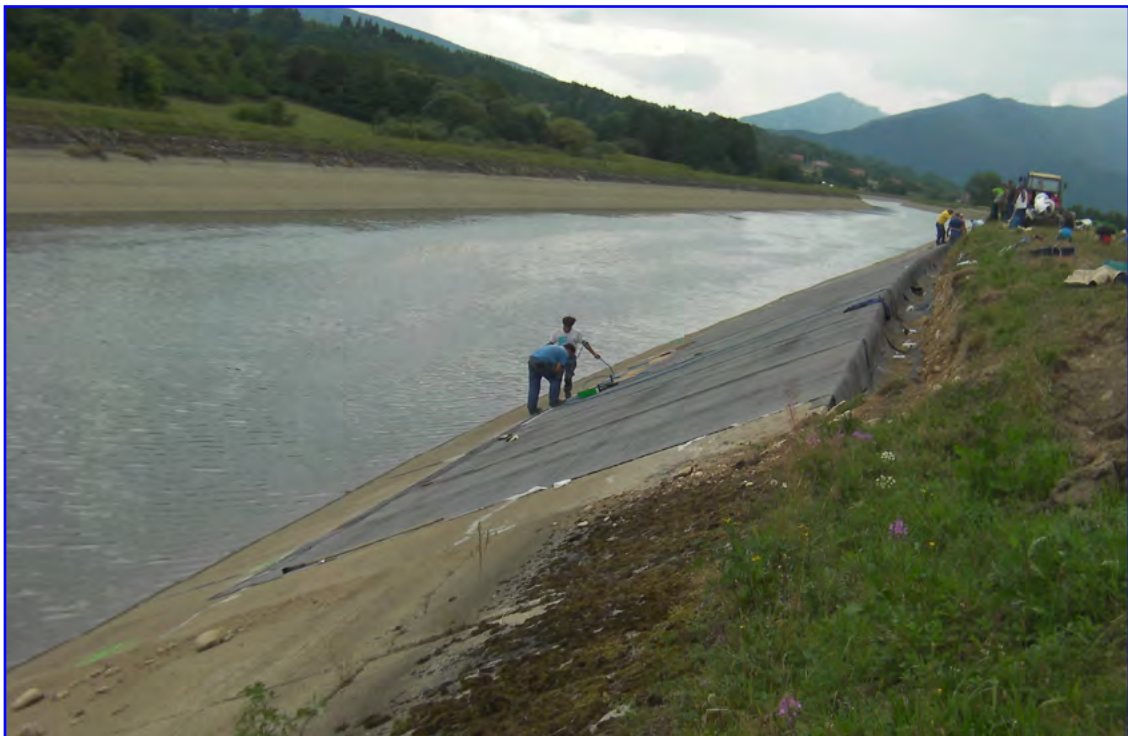
Restauración de Diques del Canal de Sucany (Eslovaquia) - 5 712 m 2 HIDRAULICA / CANALES
