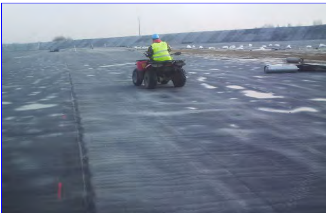
Renovación de un balsa de agua contra incendios, Grandpuits (Francia) 30 000 m 2 HIDRAULICA / Balsa
