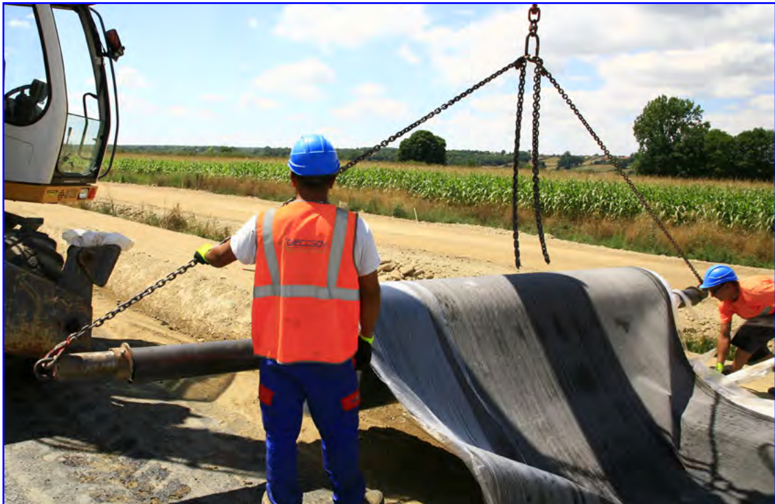
Circunvalación, Vichy (Francia) - 71 000 m 2 TRANSPORTE / CARRETERAS
