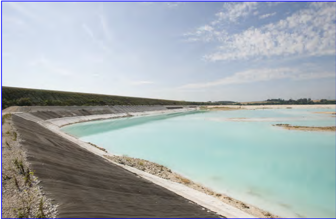
Dique, Nancy (Francia) - 60 000 m 2 HIDRAULICA / Balsa
