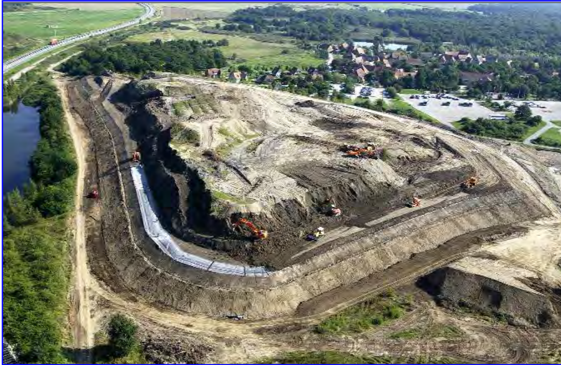
Recubrimiento del Escombrera MPDA, Colmar (Francia) - 132 000 m 2 MEDIOAMBIENTE / CONFINAMIENTO
