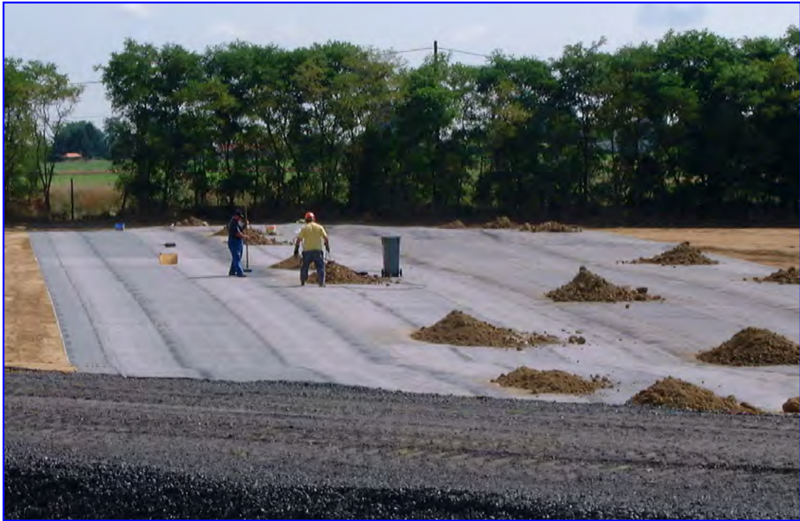
Recubrimiento de la Descarga Ugine, Mazinghem (Francia) - 160 000 m 2 MEDIOAMBIENTE / CONFINAMIENTO
