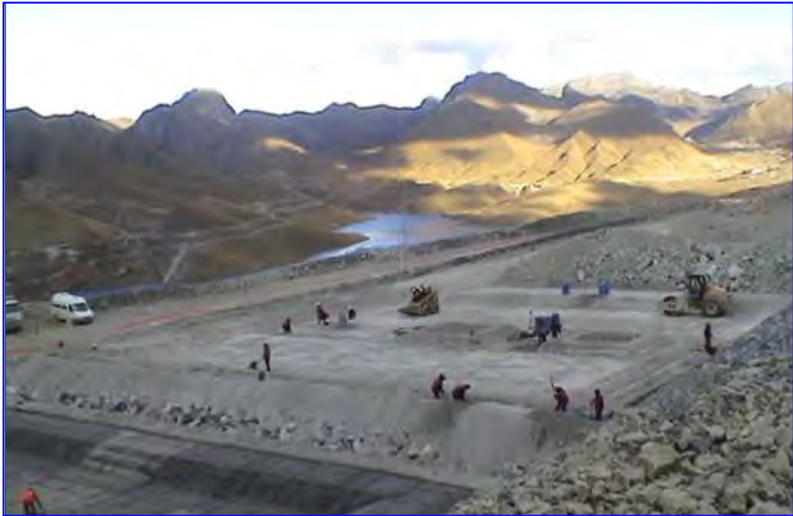
Fondo de Descarga minera, Antamina (Perú) - 8 400 m 2 MEDIOAMBIENTE / CONFINAMIENTO
