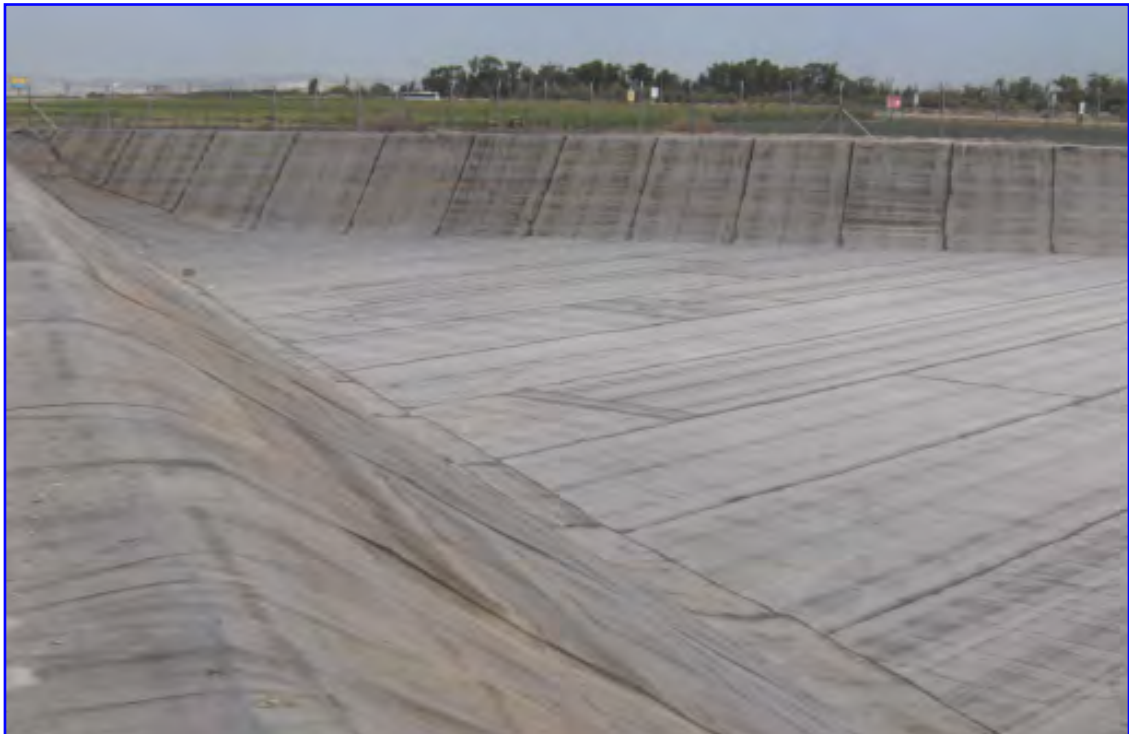
Balsa, Aeropuerto de Larnaca (Chipre) - 5 000 m 2 HIDRAULICA / Balsa
