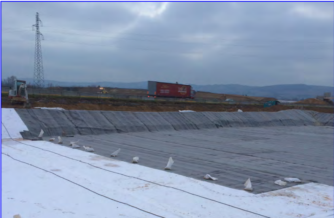
Balsa de retención, A46 (Francia) HIDRAULICA / Balsa
