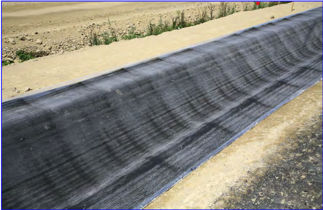
Circunvalación, Vichy (Francia) - 71 000 m 2 TRANSPORTE / CARRETERAS
