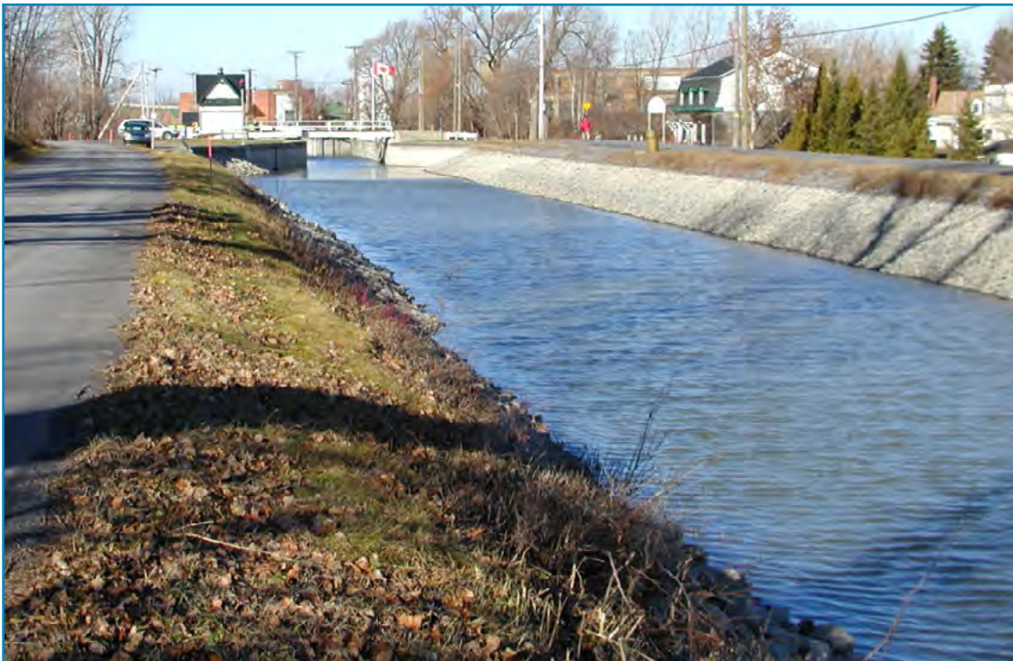
Canal, Chambly (Canadá) - 5 000 m 2 HIDRAULICA / CANALES
